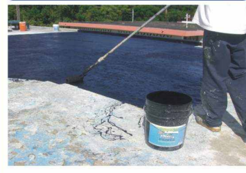
Aplicación de Primer
