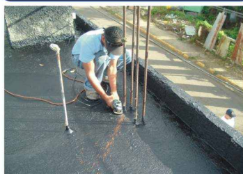
Remoción de varillas
